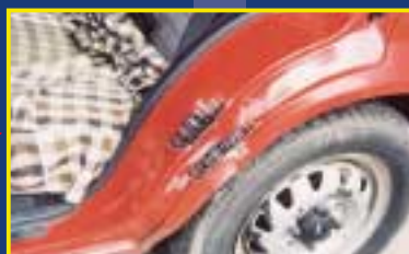
Smerigliare e saldare i Bit sulla zona ammaccata
